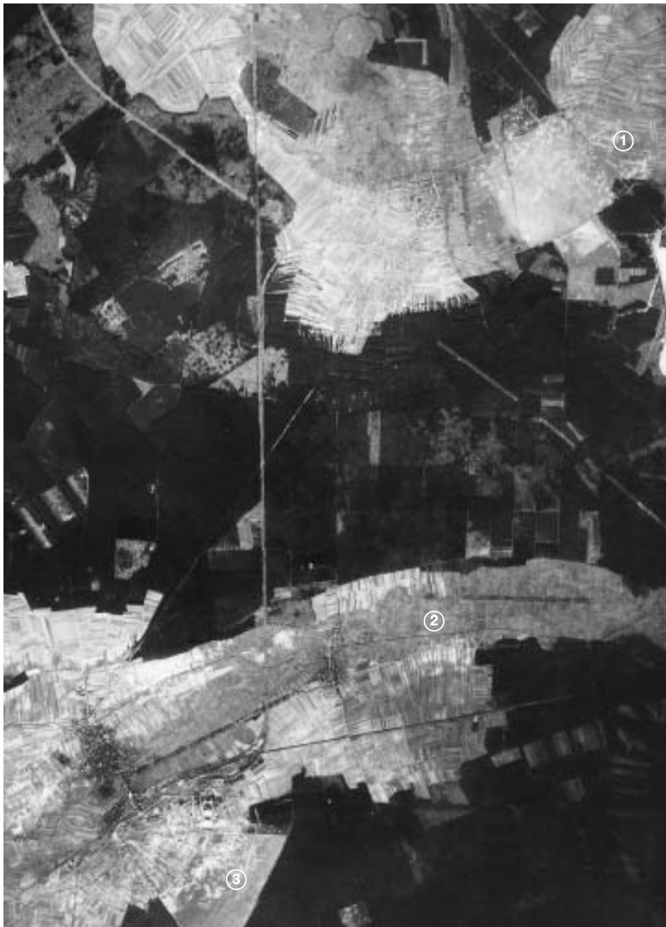
...und 14. März 1945 zeigen den enormen Baufortschritt. Rechts über der neuen Piste (2) der Einsatzhafen Zellhausen (1), links darunter der Einsatzhafen Babenhausen (3).
