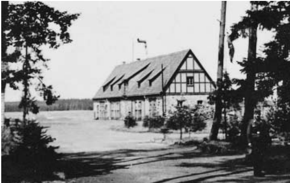
Der Geräteschuppen. Dahinter erkennbar der Windsack, mit dem die Start- und Lande- richtung bestimmt wird. Stockmann
