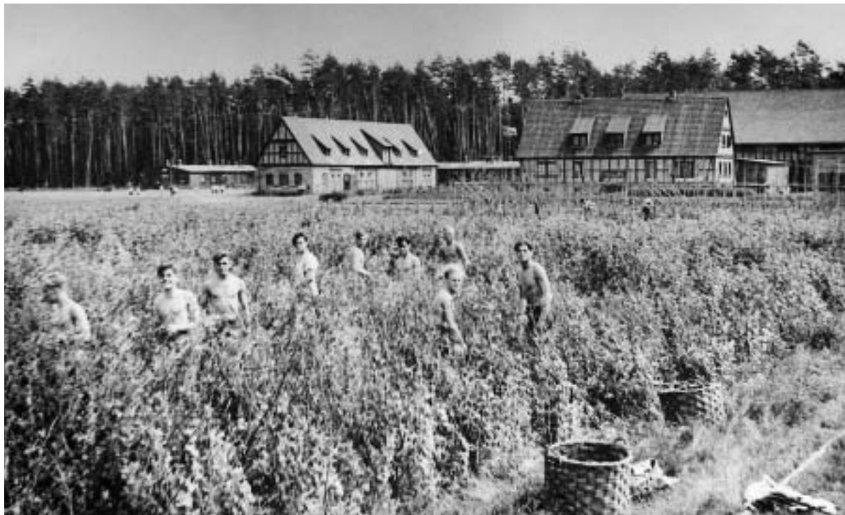
Der Gebäudekomplex aus Nordwesten gesehen – am Standort des Betrachters mündet heute Zellhausens Bensbruch- in die Nord-West-Ring-Straße. Links der Geräteschuppen, rechts daneben die Kommandantur, dahinter in paralleler Firstrichtung die E-Hafen-Scheuer. Wolfing
