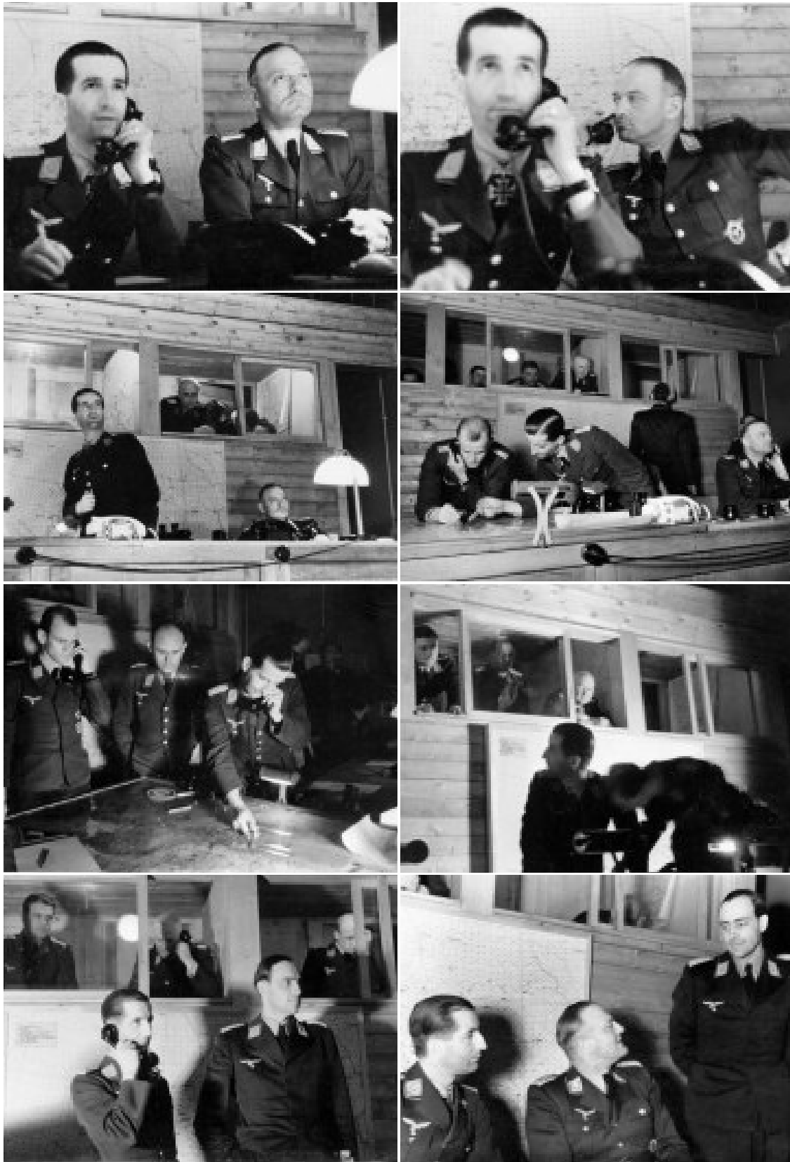
Eine Bombennacht im Gefechtsbunker der Luftflotte Reich.
